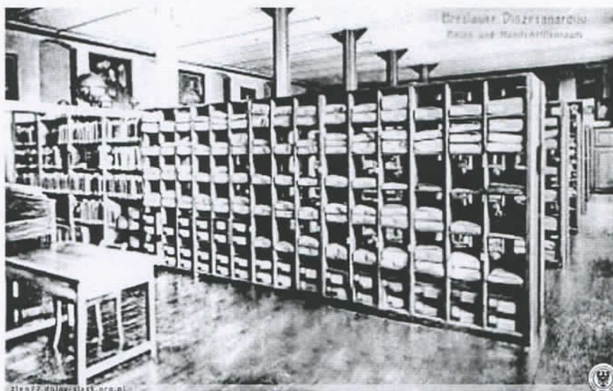
Wnętrze magazynu archiwum na II piętrze około 1930 r. Widoczne stalowe, nitowane słupy. Źródło: http://dolny-slask.org.pl , sygn. 4240982, dostęp:17.02.2016
